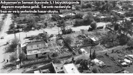
Adiyaman'ın Samsat ilçesinde 5,1 büyüklüğündeki deprem meydana geldi. Sarsıntı nedeniyle bazı ev ve iş yerlerinde hasar oluştu.
